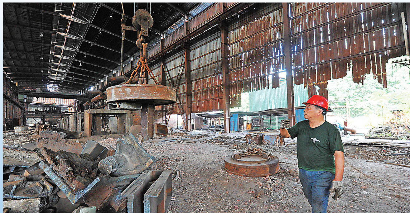
▲至今年10月底,清水塘老工业区整体搬迁改造任务基本完成,原来烟囱林立的景象已被热火朝天的施工场面取代,一座生态新城正在加快建设。图为某搬迁企业内,工人在指挥吊装天车运输拆卸后的设备
