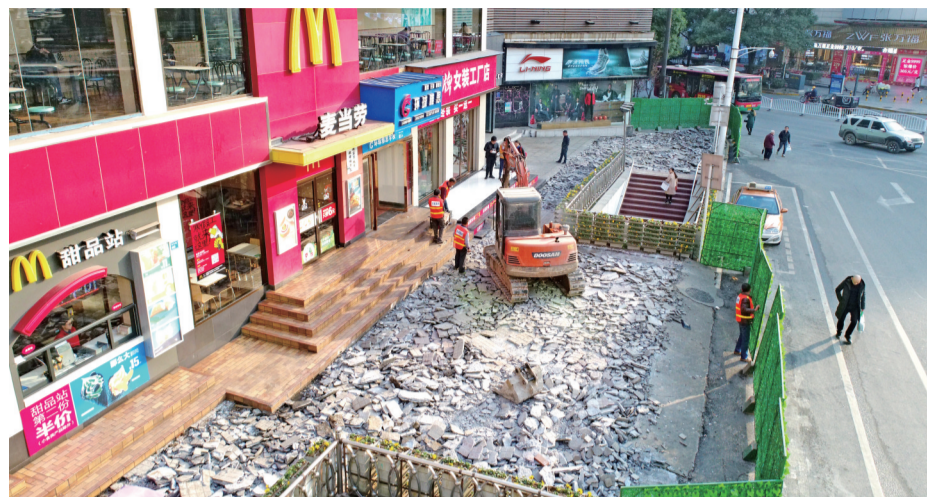
▲中心广场东南角的人行道地砖全面更换 记者 谭浩瀚 摄
