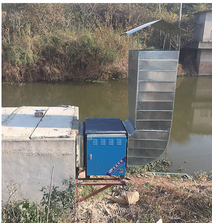
▲原来开放式的沉淀池已封闭,并安装环保装置 记者 贺天鸿 摄
