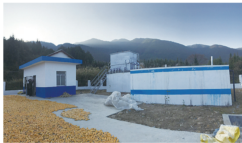
▲金花村新建成的水质处理、检测一体站
