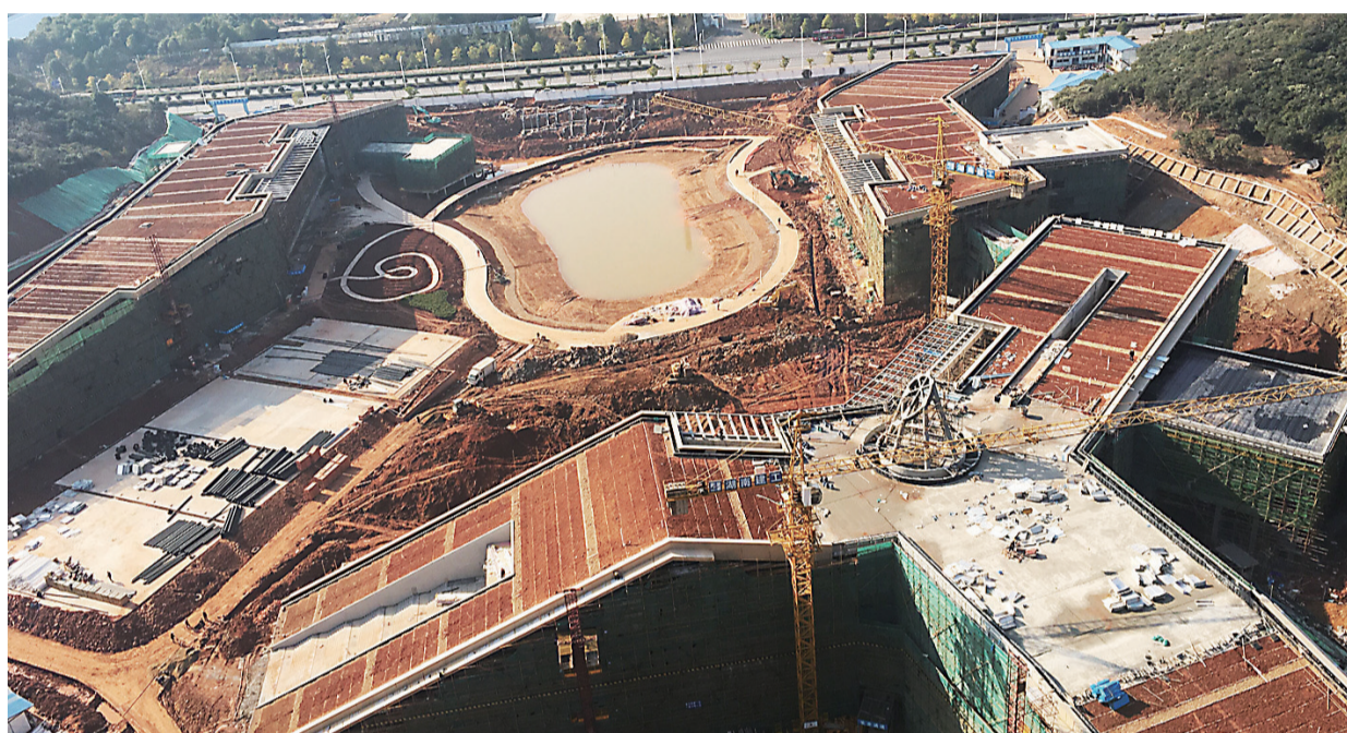
▲昨天拍摄的“三个中心”建筑工地，其主要建筑已经基本完工 记者 刘娟 摄
