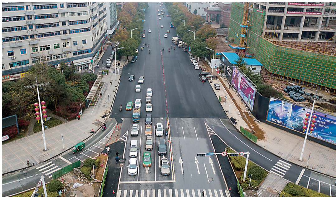
▲黄河北路天台路口至庐山路口的6个车道已通车,车辆行驶畅通 记者 刘震 摄
