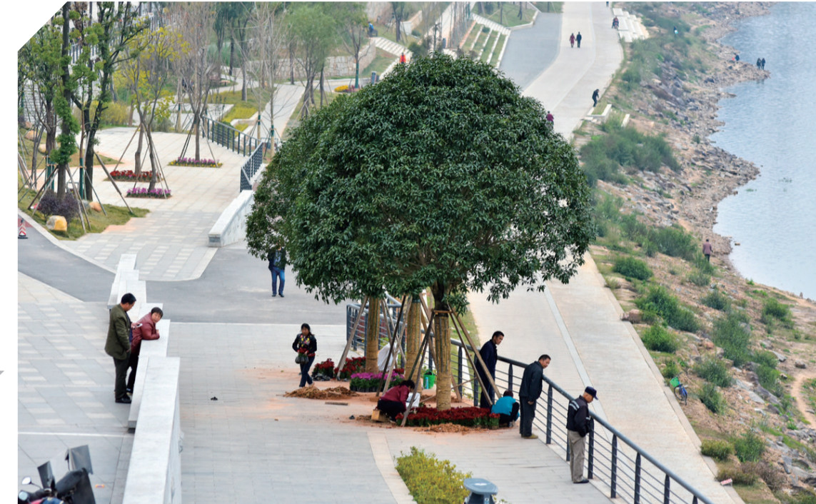
▲昨日,在河东风光带车站路与沿江路交界处,工人们忙着移植树木 记者 刘震 摄
