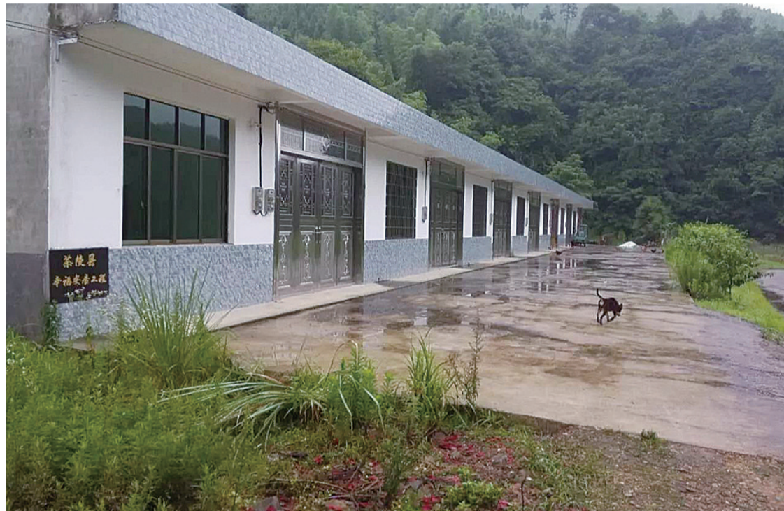
▲图为竣工后的贫困户安居房 通讯员供图
