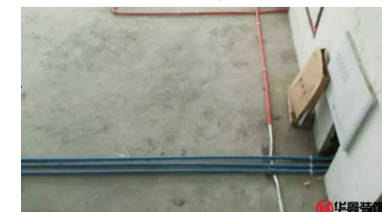
▲弱电线间距300mm,有交叉的用锡箔包好,保证弱电无干扰,有效保证弱电信号。
