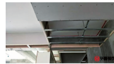
▲木工:吊顶全部用轻钢龙骨,减少今后天花变形,起到防火阻燃作用。
