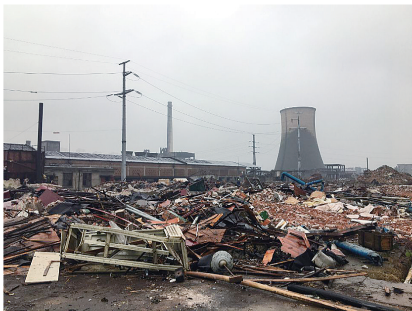
▲12月1日,清水塘福尔化工厂区被整体拆除 通讯员 申明 供图
