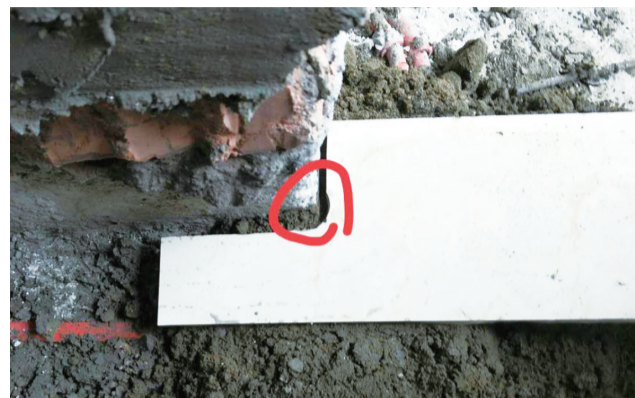
▲在房屋贴地板拐角处切7字拐角
