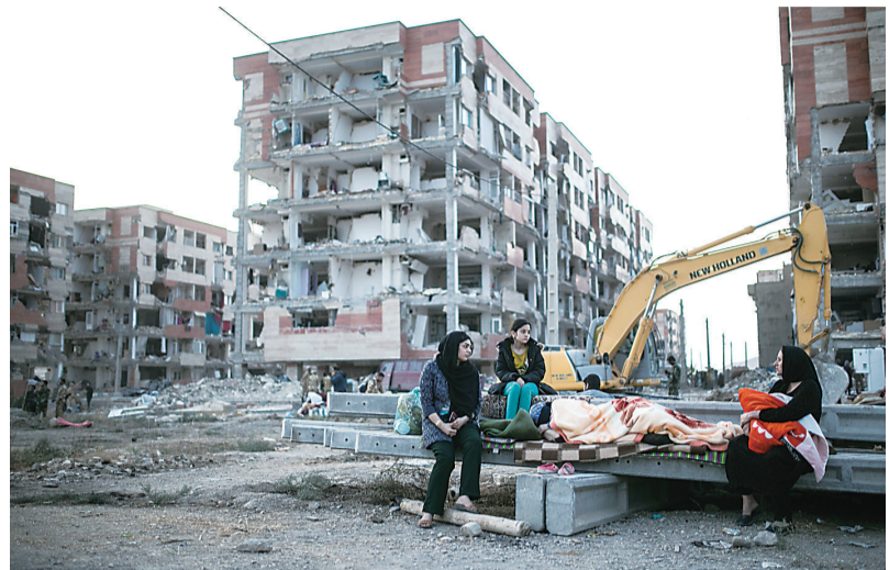
▲地震后,伊朗大量保障房公寓楼严重损毁,外墙坍塌
