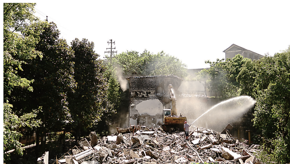
▲C地块湘氮生活区两栋楼拆除 石峰区宣传部供图
