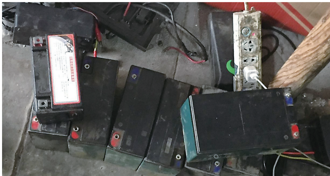
▲一家电动车维修店内随意摆放的废旧铅酸电池
