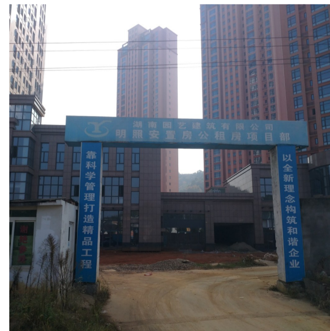
▲明照安置房公租房项目现场 记者 姚时美 摄
