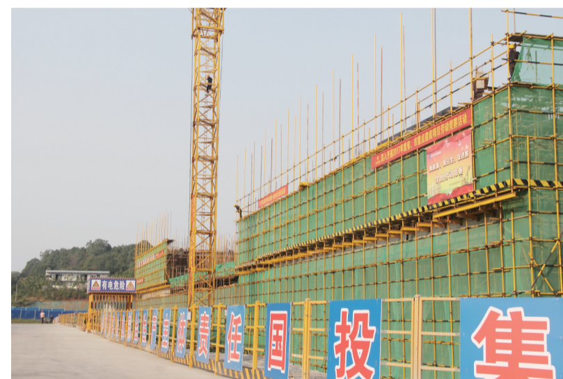
▲创业广场已完成主体工程施工,将于年底基本建成 通讯员供图
