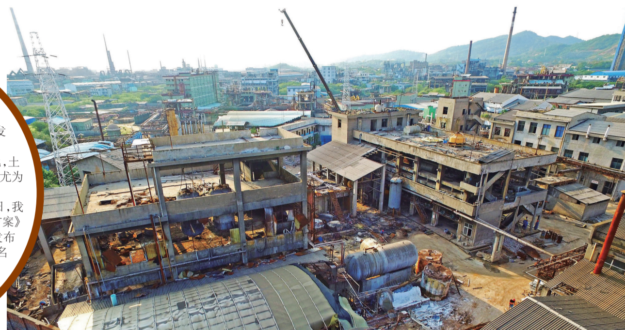
▲正在进行拆除的清水塘片区某企业 记者 谭清云 摄
