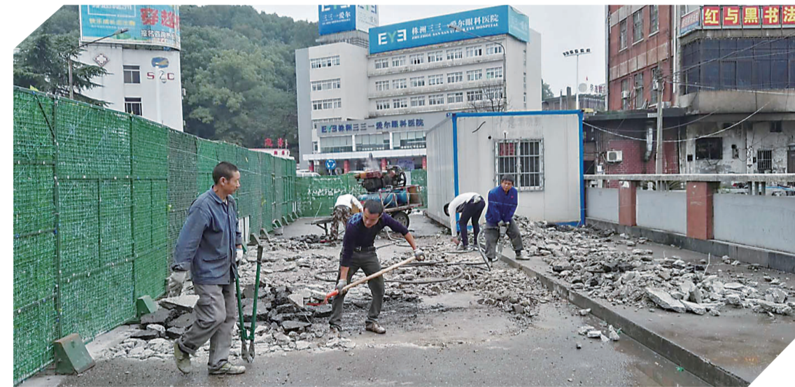
▲南华桥中修工程启动 记者 伍靖雯 摄
