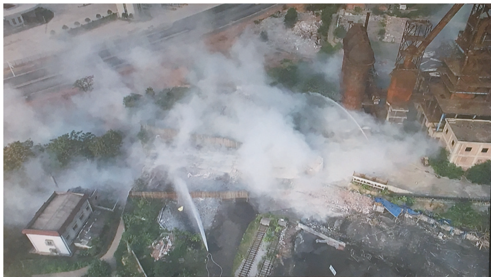
▲9月30日, 株洲钢厂最后一根烟囱爆破 通讯员 申明 供图
