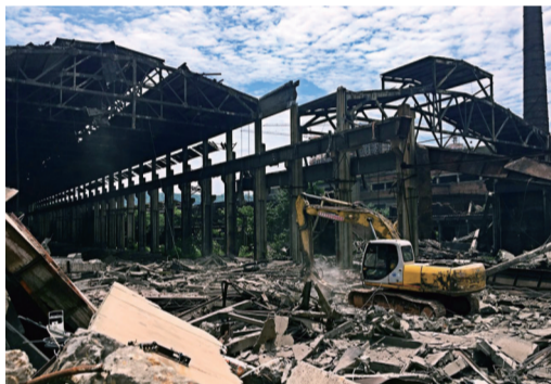
▲钢厂拆除现场 通讯员 申明供图
