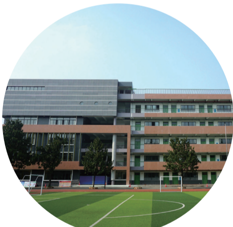
▲九方小学新建教学楼
