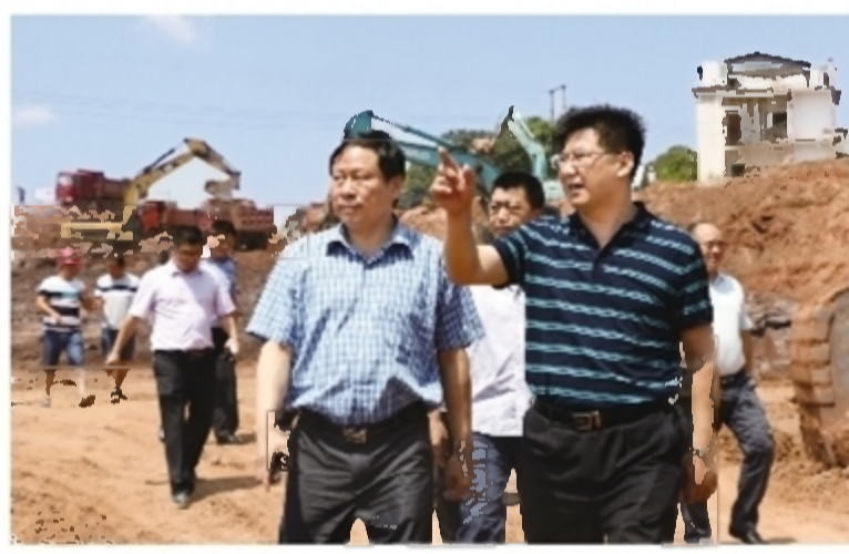
云龙示范区党工委副书记、管委会主任付华现场调度征拆工作
