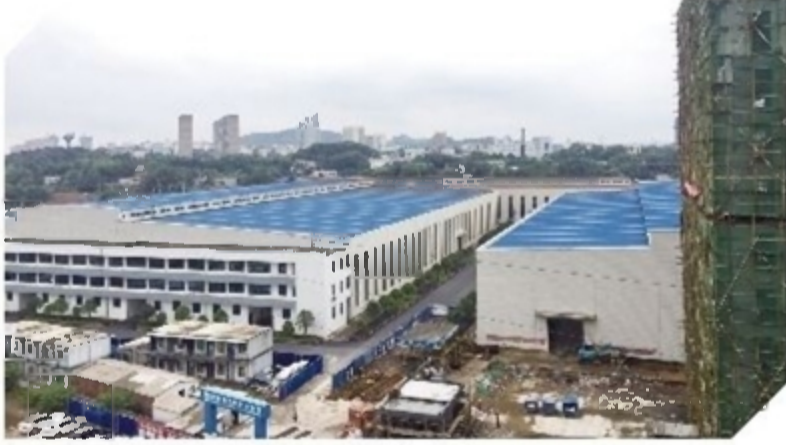
轨道交通建设的土地上一座座新厂房拔地而起
