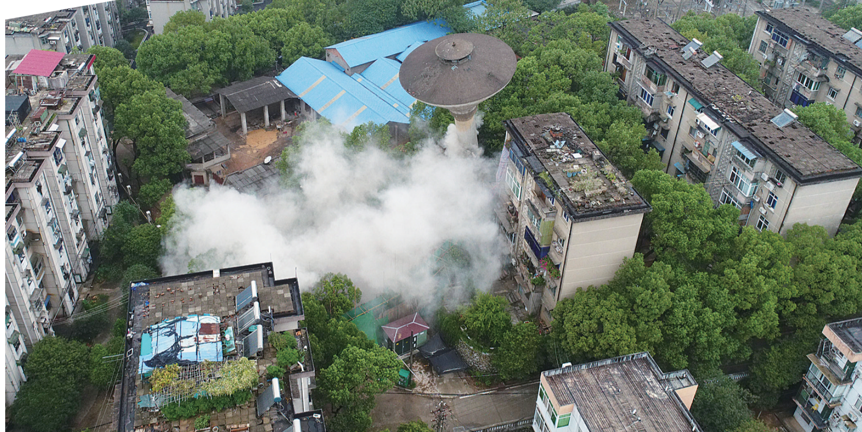
▲昨天下午,老水塔被爆破拆除瞬间 记者 谭浩瀚 摄
