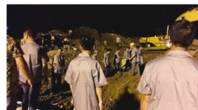
2017年7月3日项目工地防汛工作
