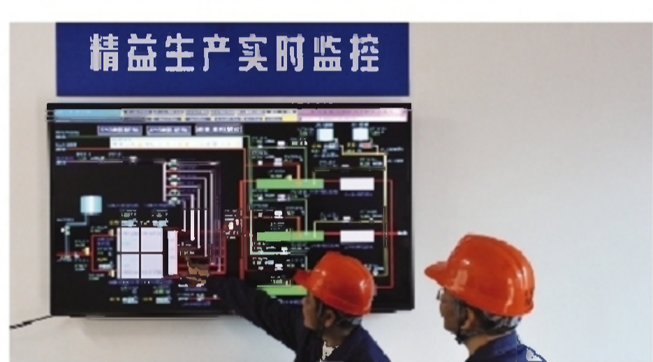
企业工作人员对厂内的污水处理工作进行实时监控。株洲日报社全媒体记者 谭清云 摄
