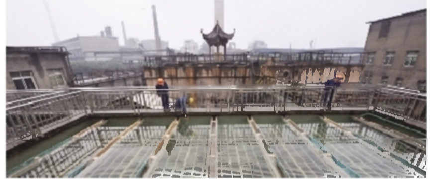
企业工作人员对厂内的污水处理工作进行巡查。株洲日报社全媒体记者 谭清云 摄
