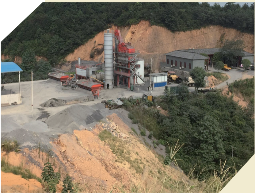
▲永盛搅拌站造成水土流失和山林破坏 记者 赵露 摄
