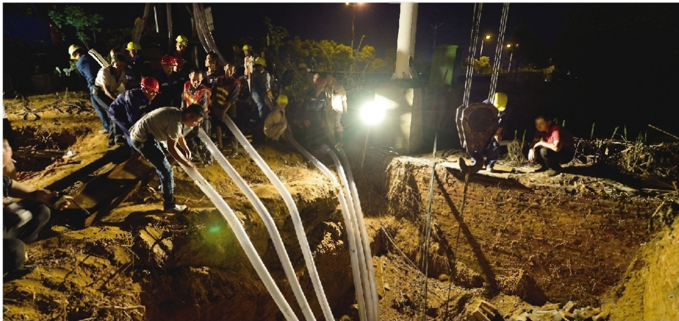
▲施工人员在连夜抢修
