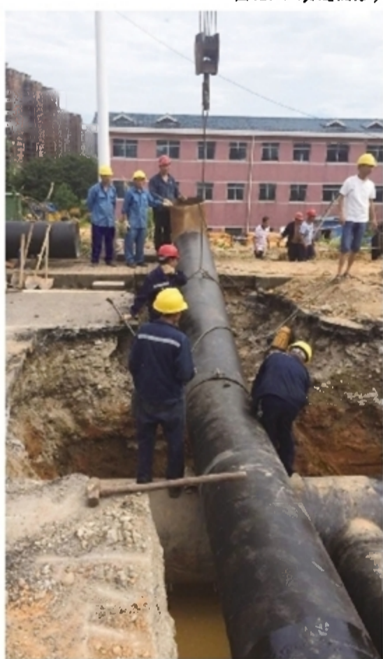
▲施工人员在竖管降地
