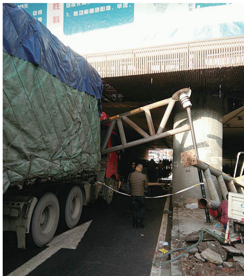
▲垮塌的限高架卡在在了挂车车头和车身中间 通讯员 供图
