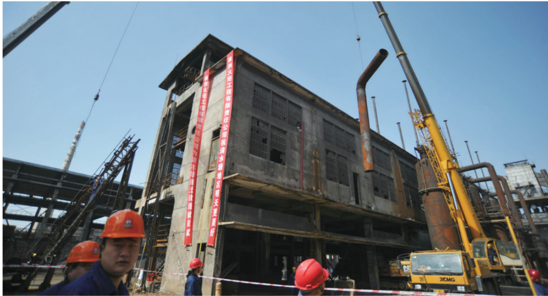
▲本月初,株冶搬迁改造拆除工程启动(资料图) 记者 周嵩 摄
