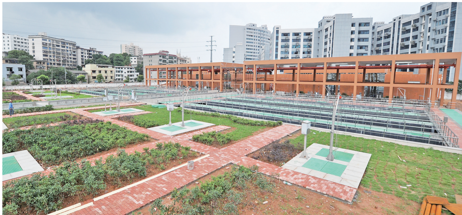
▲龙泉污水处理厂现场。今年12月底前,我市更多污水集中处理设施将建成 记者 张媛 摄
