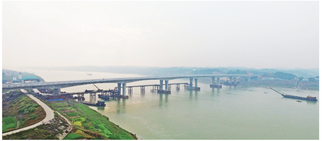
▲远眺已完工的渌口大桥 株洲日报社全媒体记者 谭清云 摄
