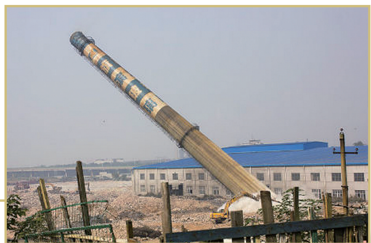
▲旗滨玻璃厂烟囱爆破拆除 资料图
