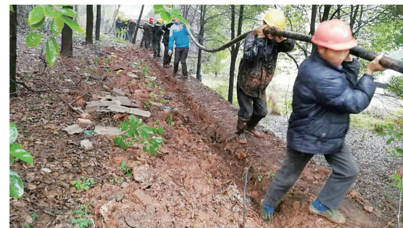
▲3月5日下午,施工人员在铺设电缆 受访者供图
