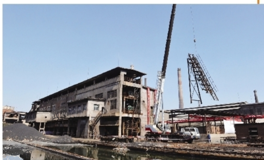
在株冶集团搬迁改造拆除工程启动仪式现场,首个钢结构体实现拆除。
