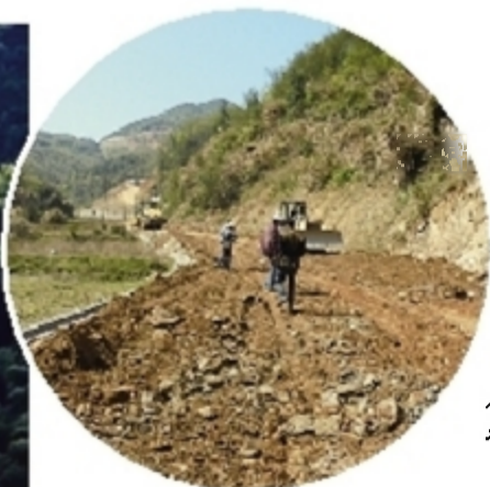
筑路工人正在紧张施工
