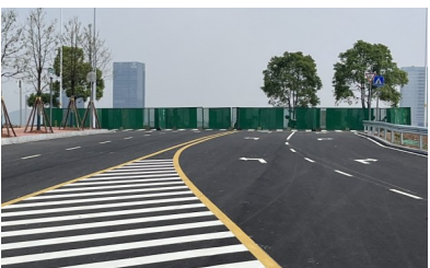
黄河北路延伸段,路口处摆放着施工围挡。 记者/刘平 摄
