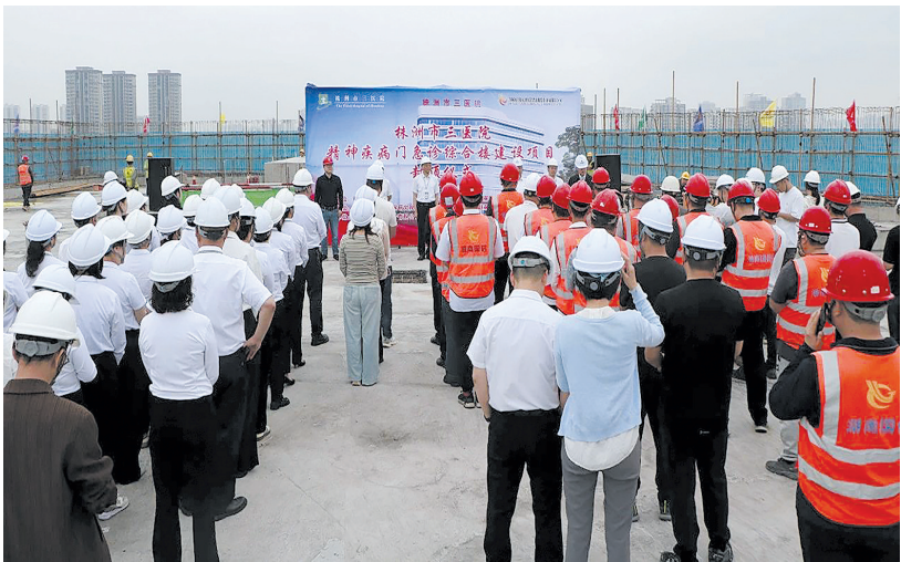
项目封顶仪式现场。通讯员供图
