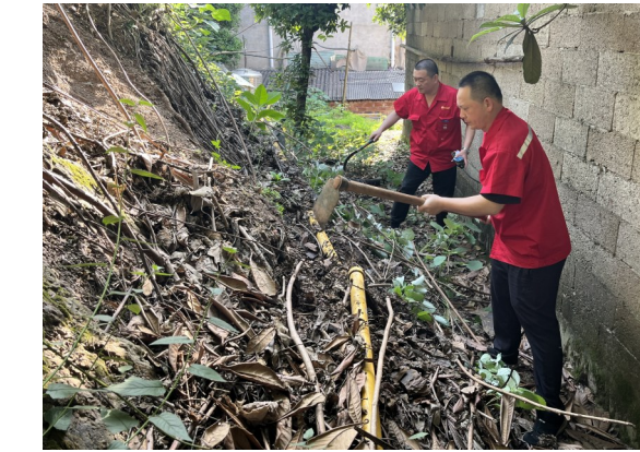
燃气巡检员对埋压户外天然气管道的泥土进行清理。 记者/刘平 摄
