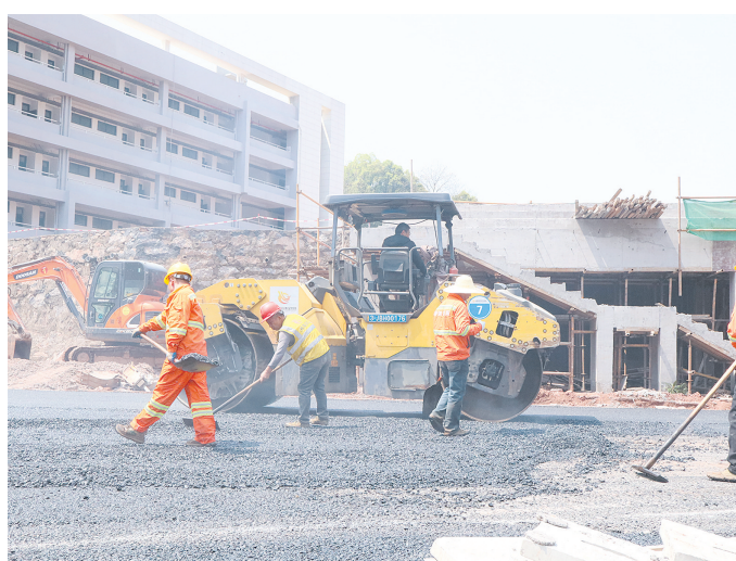
在田心中学新建的田径场内,工人们正在进行沥青摊铺作业。 记者/肖星平 摄
