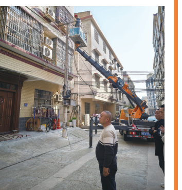
施工现场。记者/杨凌凌 摄
