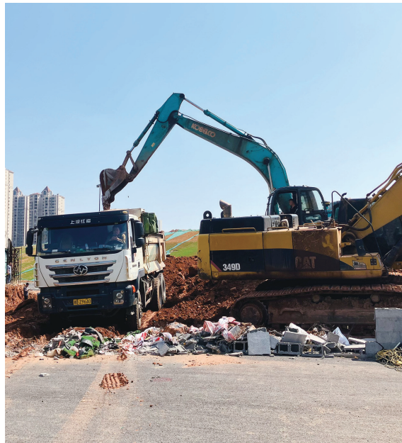
“断头路”正在进行施工。记者/姚时美 摄
