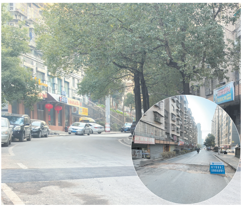
▲相关部门迅速介入,庆云山路施工区域恢复平整。
