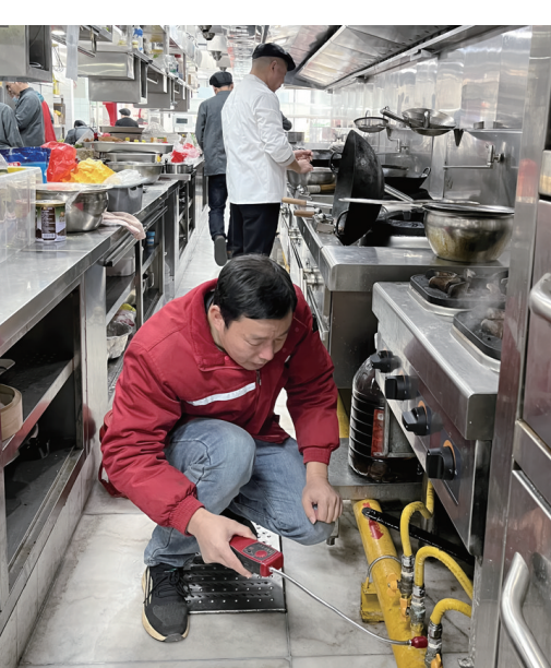
1月16日,株洲中油燃气有限公司组织燃气巡检员,对株洲汽博园内的餐饮店、酒店等工商业燃气用户,进行燃气安全隐患排查和安全宣传,为用户“安全用气平安过年”保驾护航。 株洲日报全媒体记者/刘平 摄
