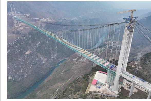
1月17日，在建世界第一高桥——贵州六安高速公路花江峡谷大桥成功合龙，为今年通车运营打下坚实基础。项目资料显示，大桥为钢桁梁悬索桥，全长2890米，其中主桥跨径1420米，桥面至水面高度625米。建成后，会成为新的世界第一高桥、世界第一的山区跨径桥梁。
