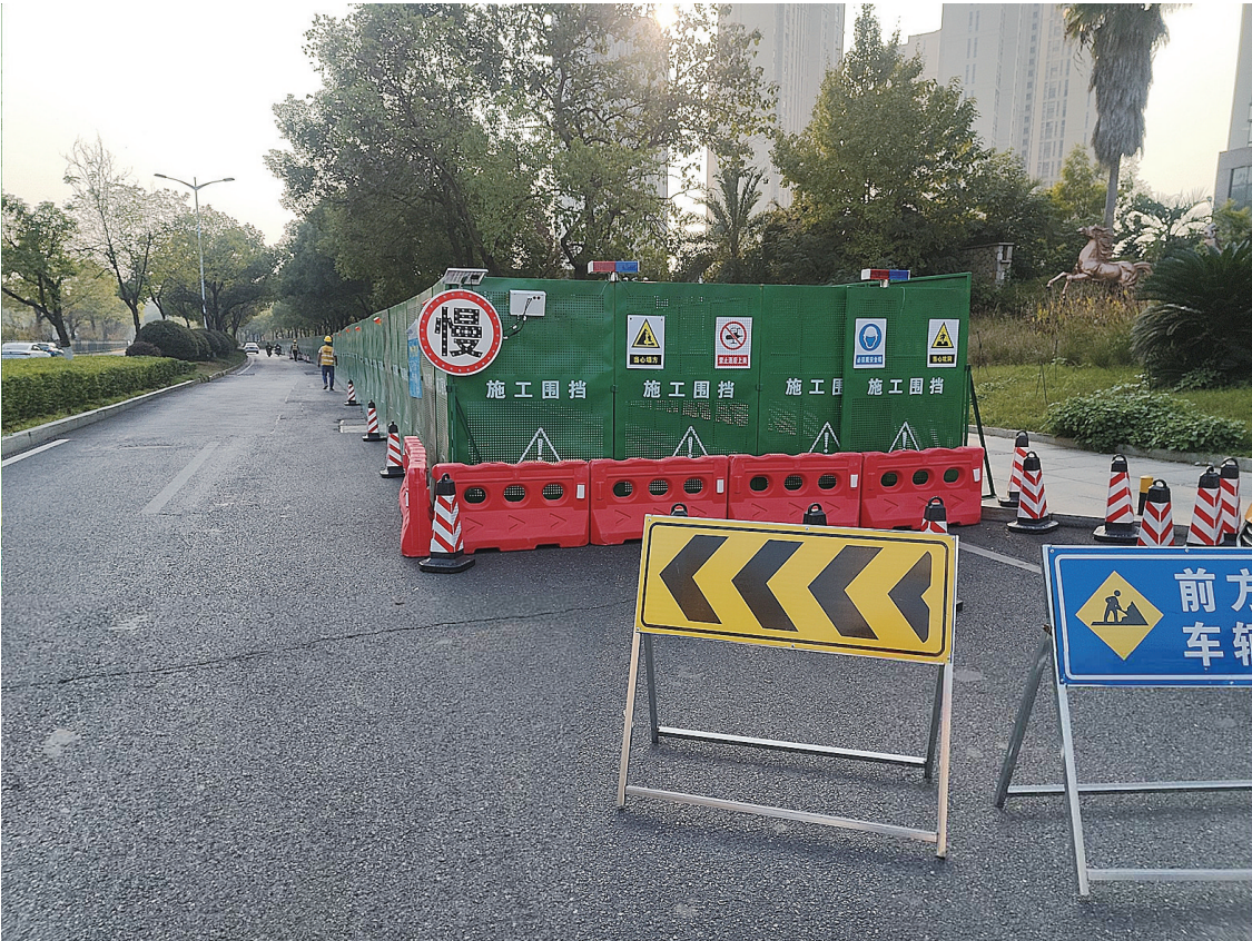
响田西路北辅道雨污分流改造施工围挡现场,通讯员供图
