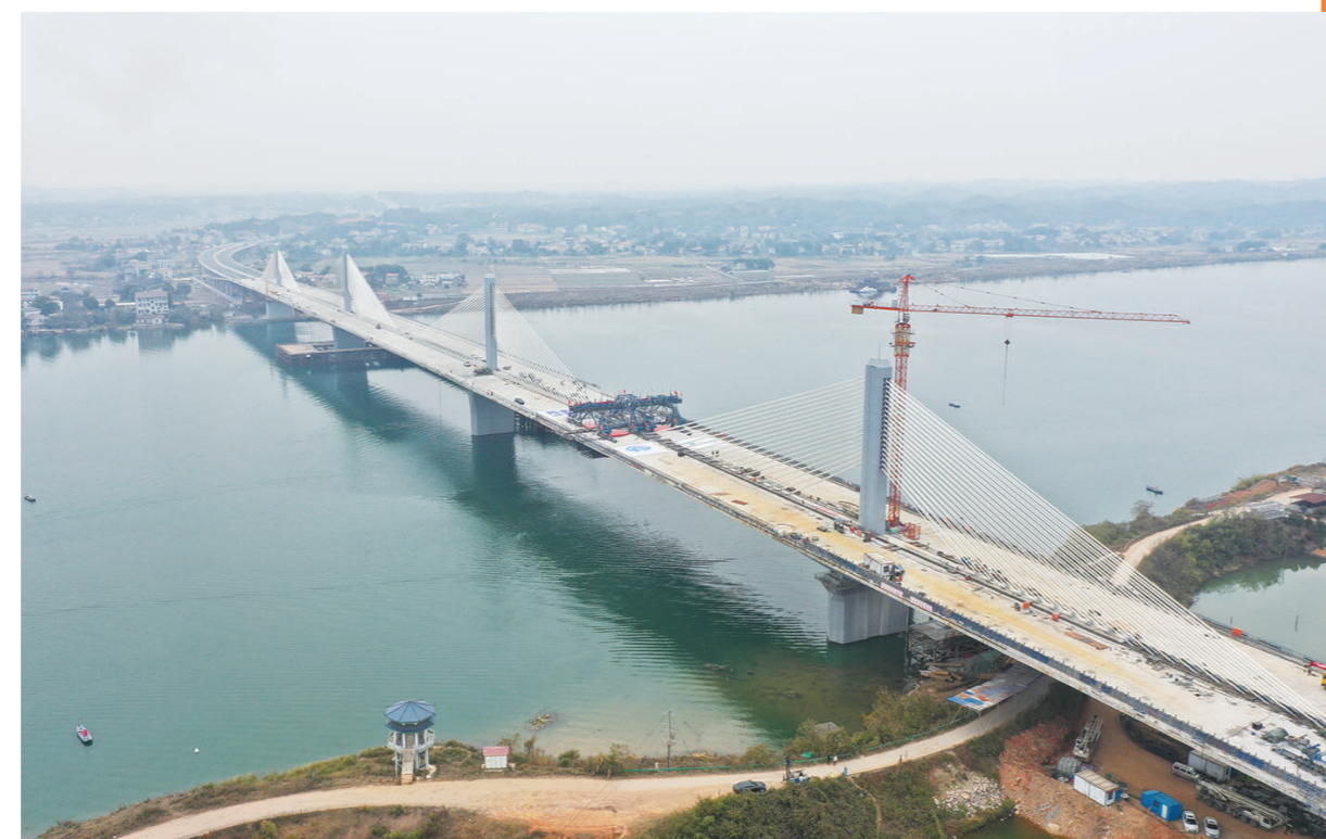
醴娄高速株洲湘江特大桥全桥合龙施工现场,株洲日报全媒体记者/谢慧 廖明 摄
