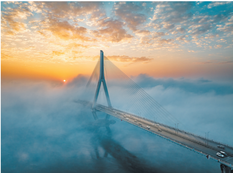
建宁大桥。石彦科 摄
