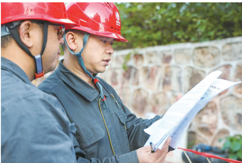
陈焱(右)驻守在施工现场。受访者提供
