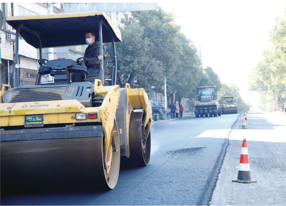
12月1日,国道G322线茶陵县枣市镇侯家村段公路修路现场。通讯员/谷经华 摄
